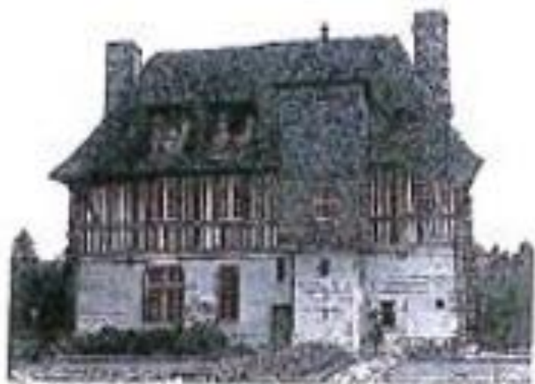
Façade Ouest avec les lucarnes, la saardie et la cheminée rétablies. (Cl. M. Davy)
